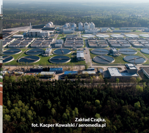
Stacja ozonowania pośredniego i filtracji na węglu aktywnym, fot. Studio Awokado
